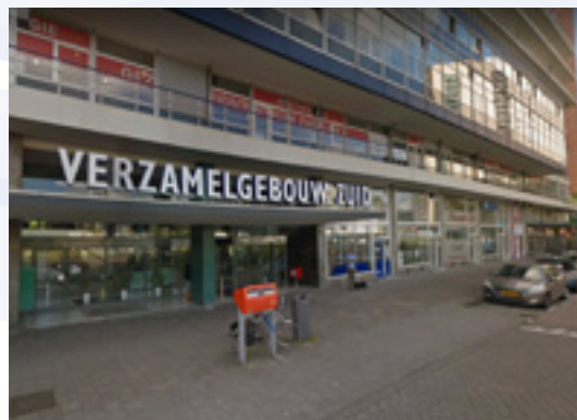
Standort Rotterdam: Haupteingang.
