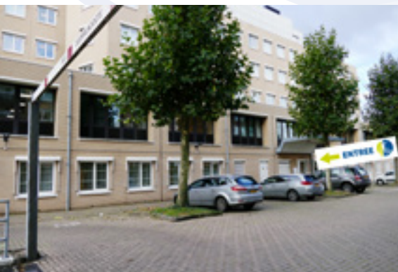
Standort Roermond: Haupteingang hinten.
